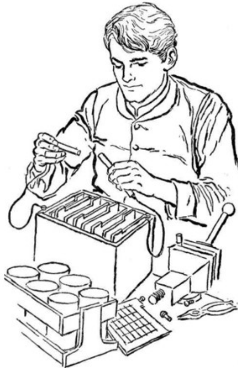
Edison trabajando en la batería eléctrica
