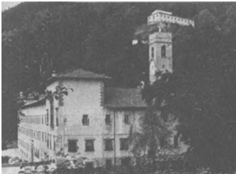
Una de las fachadas del monasterio de Vallombrosa con la torre de la iglesia.
